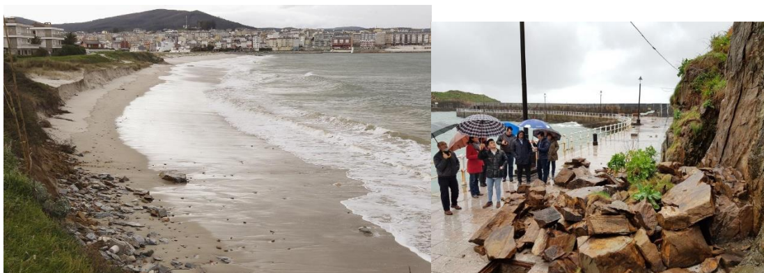
Fig. 29. Foto izquierda) erosión y retroceso de la playa de Barreiros (Lugo) durante el evento de febrero 2020; foto derecha) desprendimiento de rocas en Cudillero (Asturias) en marzo 2018.
